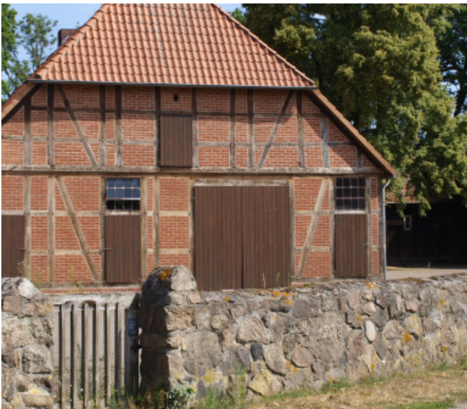
Abb. 9 ausgemauertes Fachwerk
