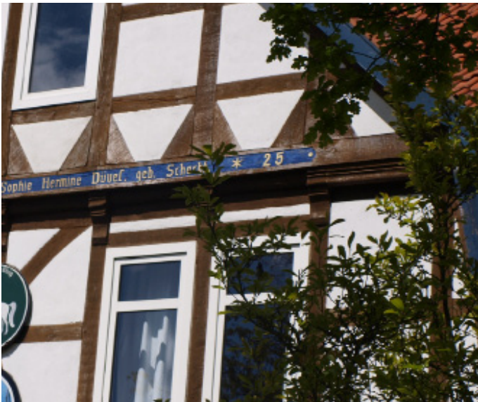
Abb. 8 mit Lehm verputztes Fachwerk
