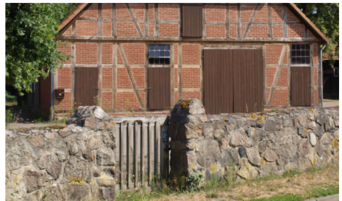
Abb. 22 Einfriedung mit Natursteinmauer und Holzpforte
