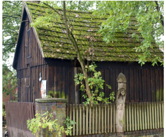
Abb. 13 Nebengebäude mit typischer Boden-Deckelschalung aus Holz
