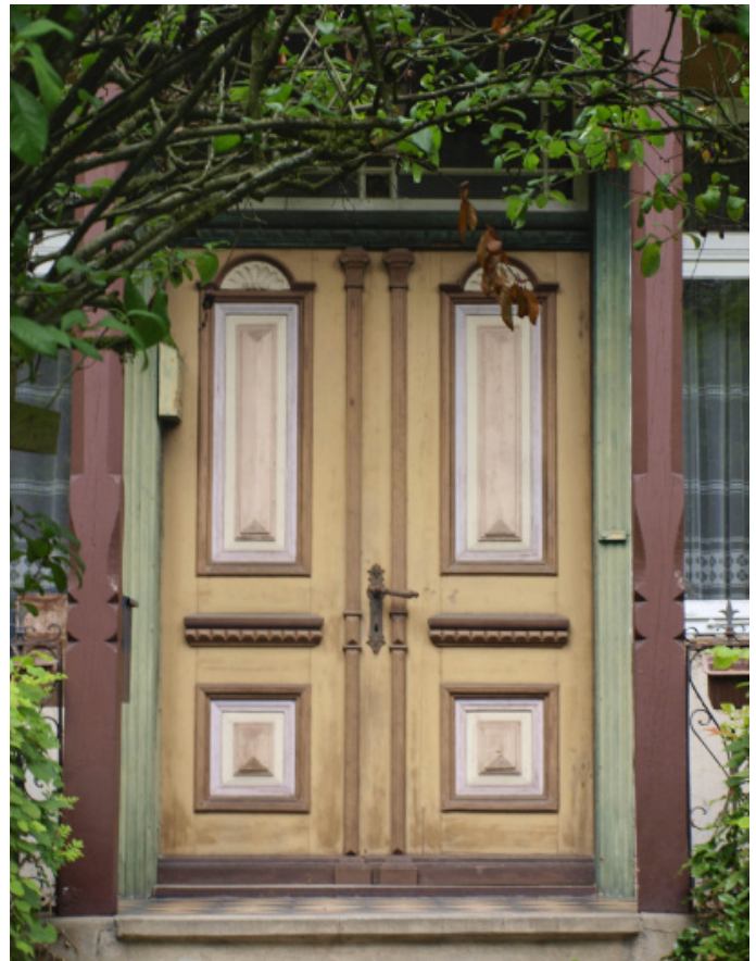
Abb. 17 Gut erhaltene Eingangstür aus Holz
