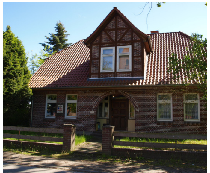
Abb. 7 Dach mit Giebelgaube
