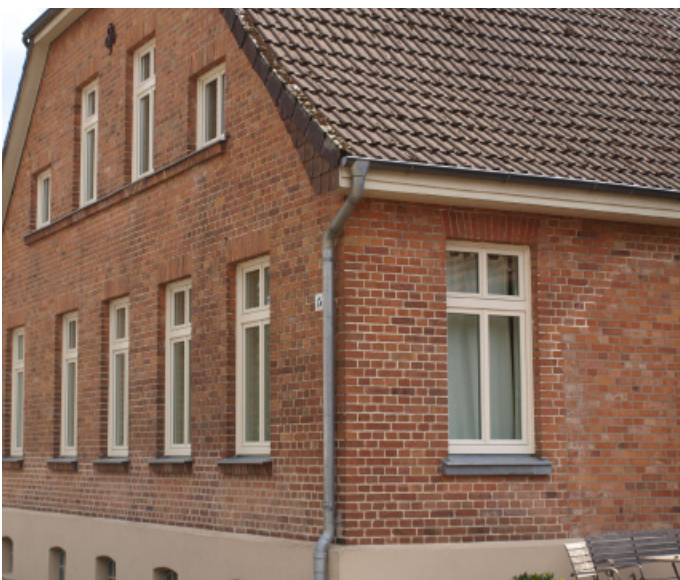
Abb. 10 massiver Ziegelsteinbau
