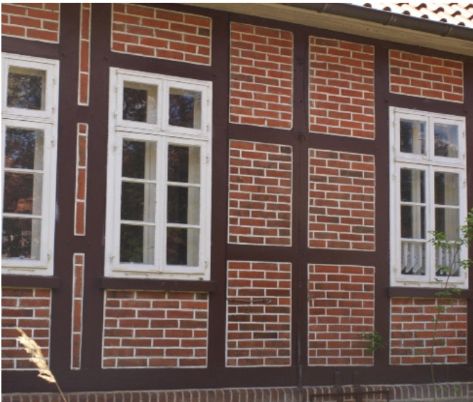
Abb. 15 Doppelte Holzfenster mit Kämpfer
