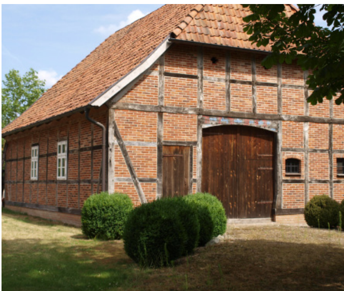
Abb. 4 Fachwerkgebäude mit Krüppelwalmdach
