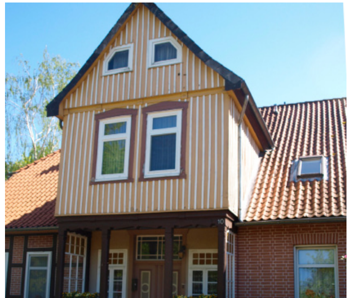
Abb. 12 Zwerchhaus mit Holzverkleidung
