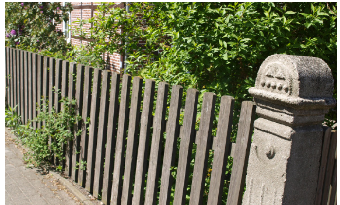
Abb. 21 Staketenzaun mit Steinsockeln
