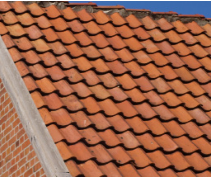
Abb. 2 Dacheindeckung mit Hohlfalzziegeln
