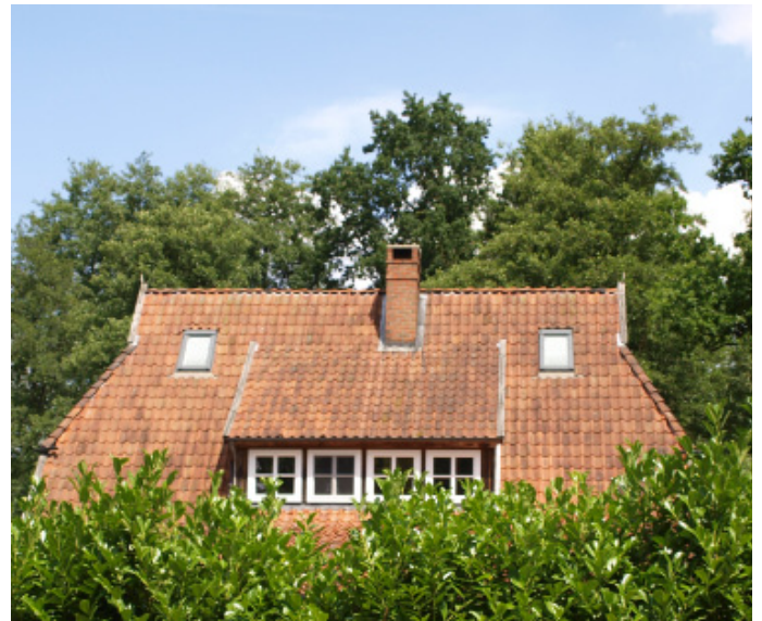
Abb. 5 Dach mit Schleppgaube
