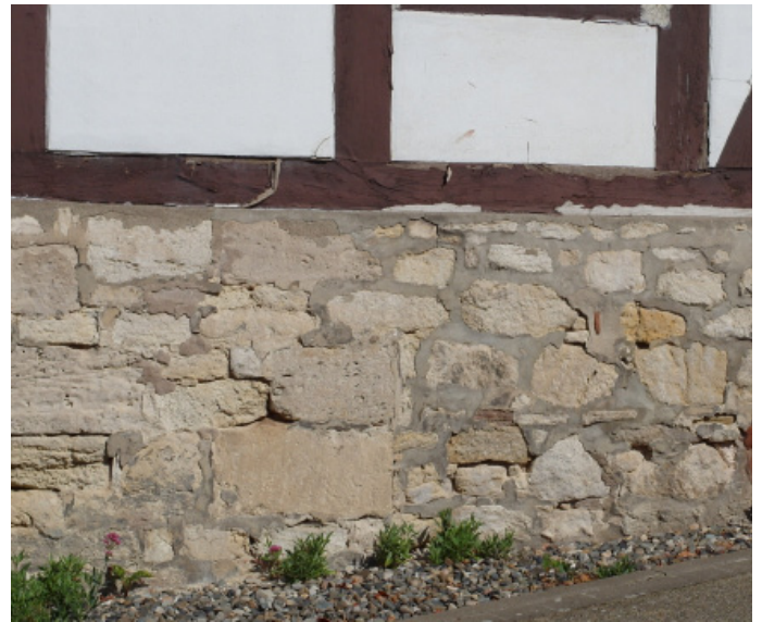
Abb. 11 Natursteinmauerwerk als Sockel unter dem Fachwerk
